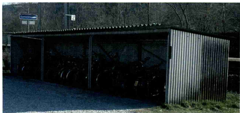
Velounterstand in Guntershausen, vorher.
